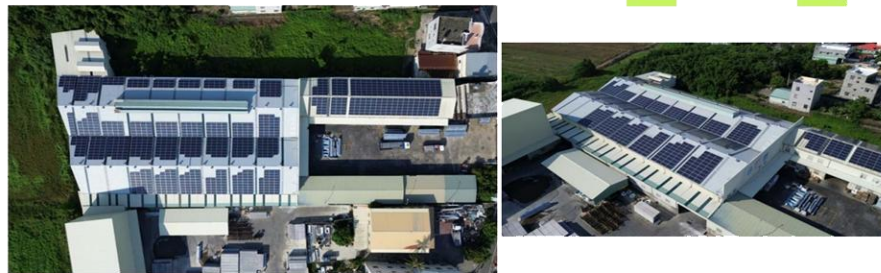
太保 - 非鐵工業 237.82kW 鐵皮型
